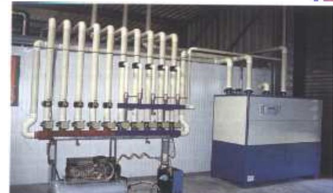
Une cuve travaille en adsorption, l'autre est en régénération
